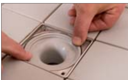
23 Avant la mise en service, dévisser la grille en acier inoxydable et contrôler la bonne fixation du siphon en appuyant dessus (le cas échéant, graisser le joint torique).
