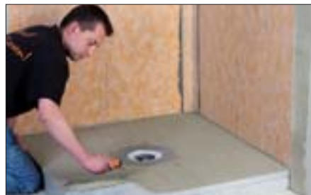
17 Déposer du mortier-colle sur le reste de la surface (spatule crantée de 3 x 3 mm ou de 4 x 4 mm)
