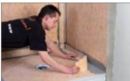
20 b Réaliser également l'étanchéité des liaisons sol/mur avec la bande Schlüter KERDI KEBA collée avec la colle Schlüter®-KERDI-COLL.
