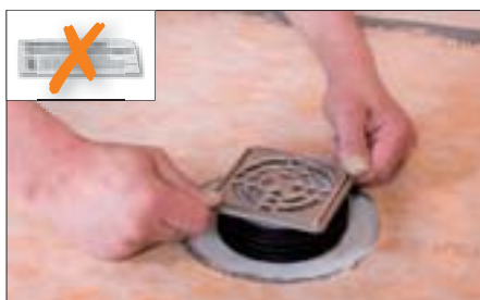
21 Insérer la grille en acier inoxydable avec son support dans l'avaloir rapporté.
