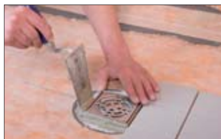
22 Caler la grille en acier inoxydable avec du mortier-colle et l'ajuster à la hauteur des carreaux.
